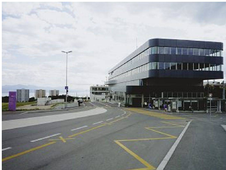
Station Vennes, Blick Richtung Süden. – Bild: Gian-Marco Jenatsch
