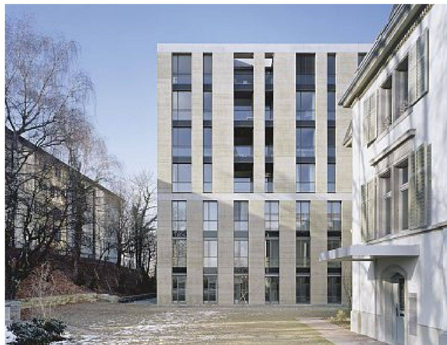
Wohngebäude Malzturm, rechts das Braumeisterhaus
