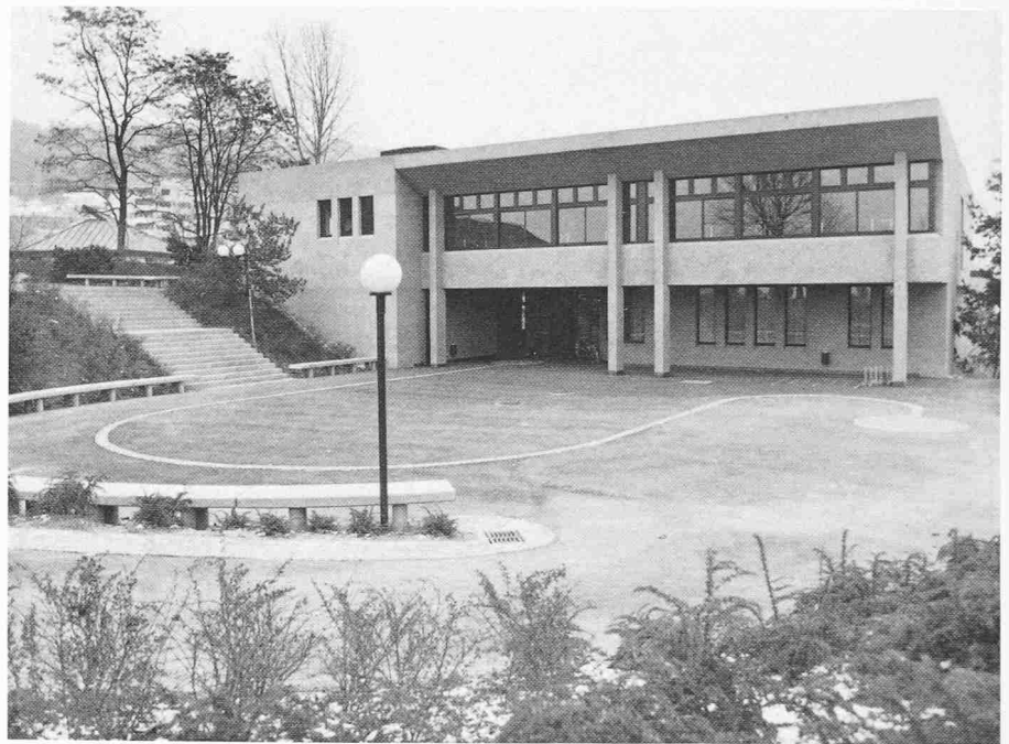
Ansicht von Westen, Pausenplatz
