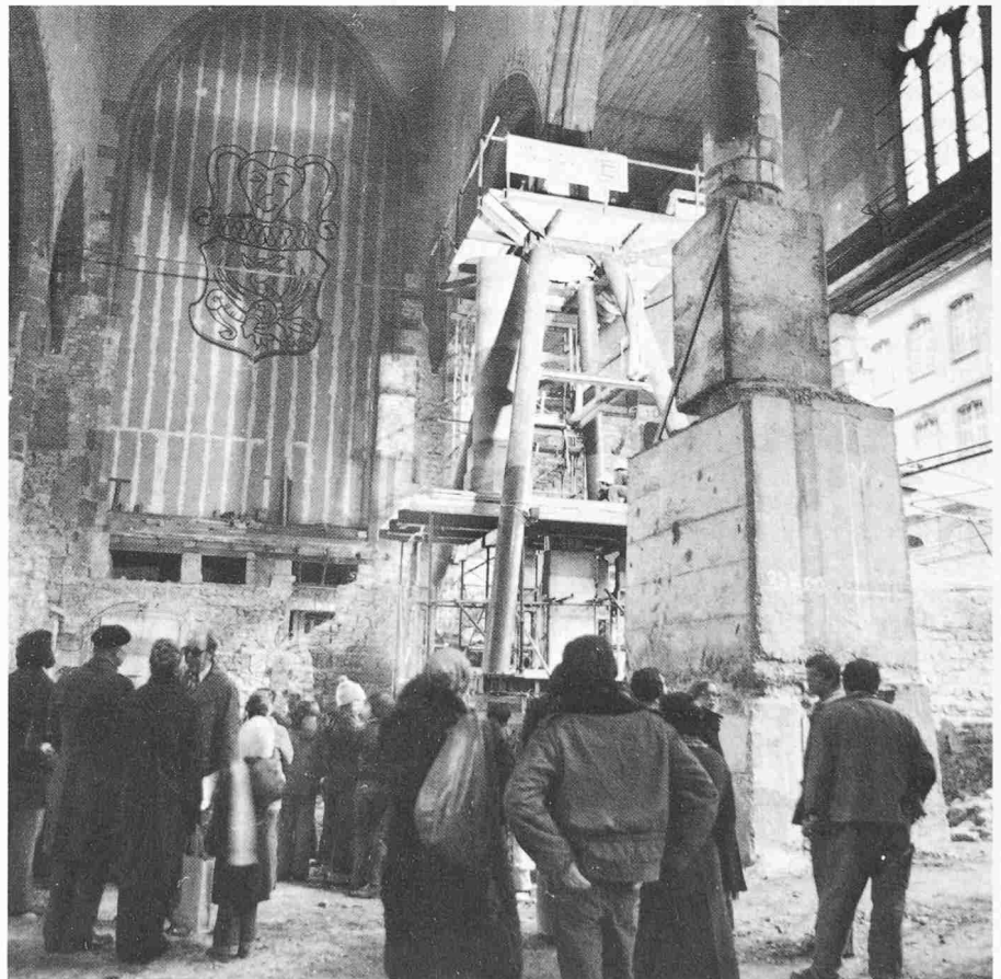
Bild 12. Pfeiler C 7. Der neue Buntsandstein-Pfeiler ist seitlich mit Hilfe eines Pneukranes zusammengebaut worden; nun wird er unter die Trennfuge eingefahren. Eine Schulklasse schaut interessiert zu (Aufnahme: 16.12.76)
