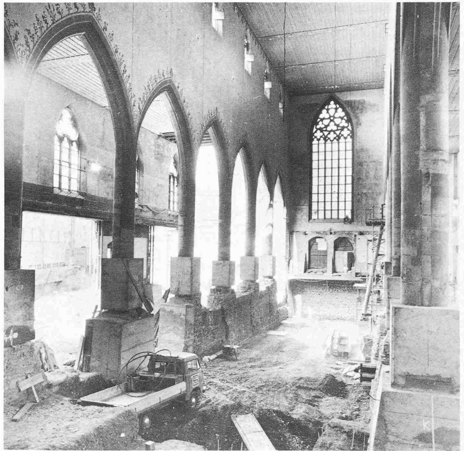
Bild 7. Das Untergeschoss ist ausgehoben. Links sieht man die freigelegte Grundmauer der Nordfassade der ersten Barfüsserkirche. Die Baumeister der zweiten Kirche haben sie als Fundament für die südliche Pfeilerreihe (Achse C) benützt (Aufnahme: 30.4.76)
