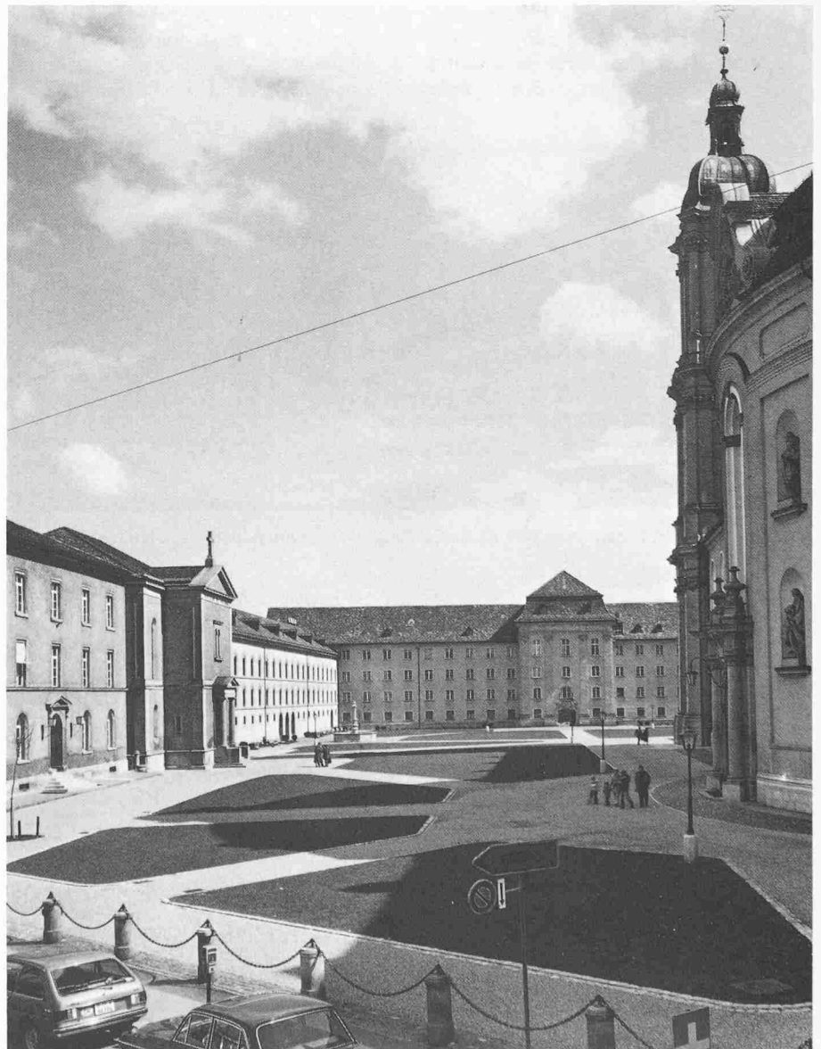
Der Klosterhof St. Gallen, eine kulturhistorisch und städtebaulich bedeutungsvolle Platzanlage von nationaler Bedeutung. Ansicht von Westen; links: Schule, Kinderkapelle und Zeughausflügel von Architekt Felix Wilhelm Kubly 1838–1841 gebaut; Mitte: Neue Pfalz von Ferdinand Beer 1767–1769; rechts: Kathedrale von Peter Thumb (1. Etappe Schiff und Chor 1755–1760) und Michael Beer (2. Etappe Chor und Türme 1761–1767)
