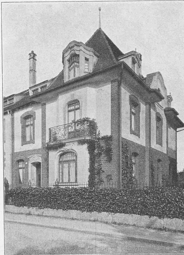
Abb. 7. Haus an der Wartenbergstrasse Nr. 41. Erbaut von Suter & Burchardt , Architekten in Basel.
