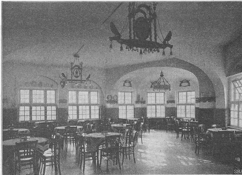
Abb. 6. Das Gastlokal. Blick in den östlichen Erker.
