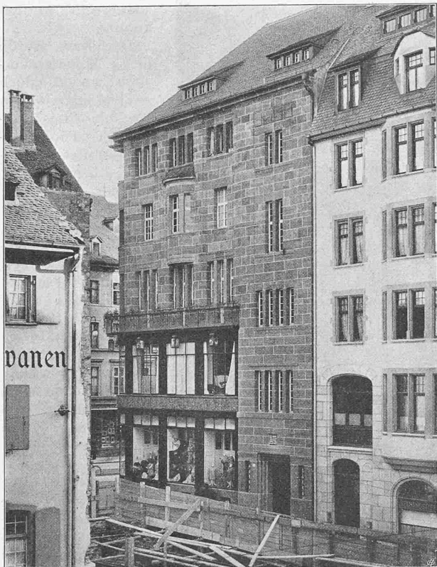
Abb. 8. Fassade am Tanzgässlein.
