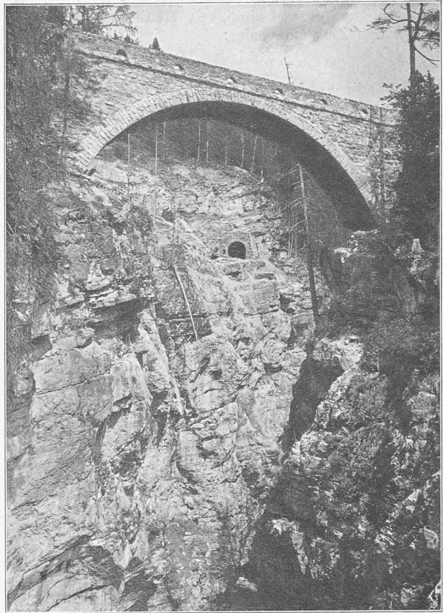
Abb. 19. Gewölbte Brücke der Zufahrtsstrasse nach Jennisberg und unteres Portal des Wiesener Tunnels II.
