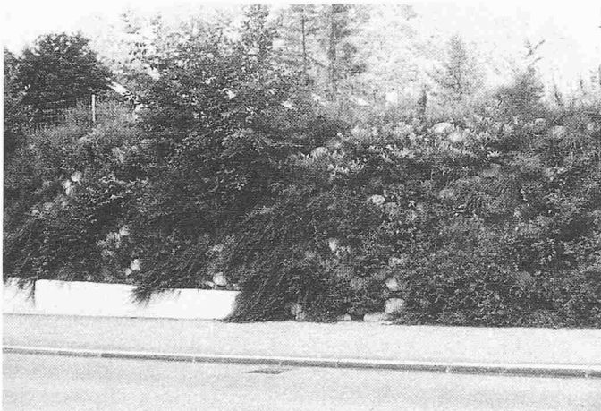
Bild 1. Kreuzbuchstrasse Luzern, Böschungssteine Typ «Big-Löffel»
