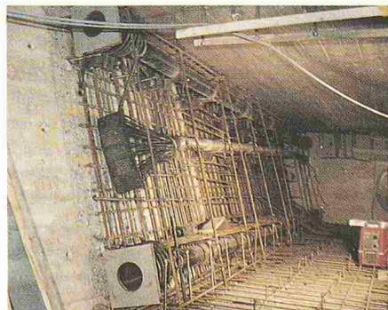
Bild 10. Brückentrog-Verstärkung, Vorspannung und Armierung Bildautor: A. von Glutz
