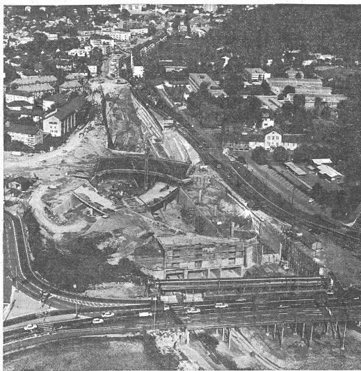
Baustelle der Expressstrasse SN 1 auf dem Milchbuck mit dem Portalgebäude des Milchbucktunnels und dem Kreuzungsbauwerk; im Hintergrund der bereits zugedeckte «Tunnel Winterthurerstrasse» der SN 1 (Photo Comet)
