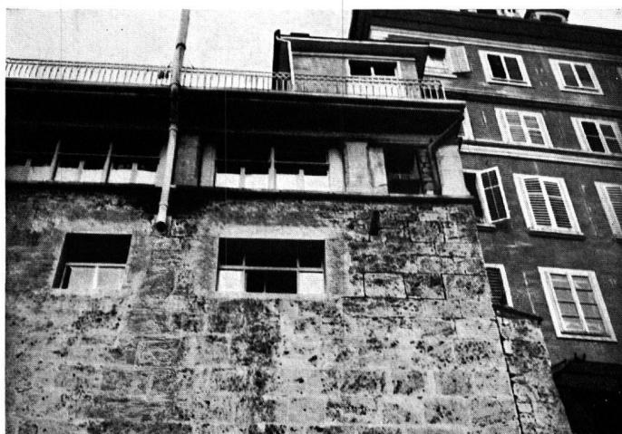
Fig. 11. Mur crénelé derrière l'hôtel de Zaehringen
