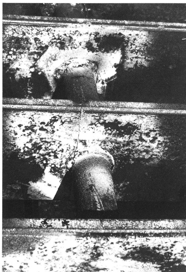
Bild 6. Bei den Distanzhaltern gebrochene Rechenstäbe. (Photo RADAG)
