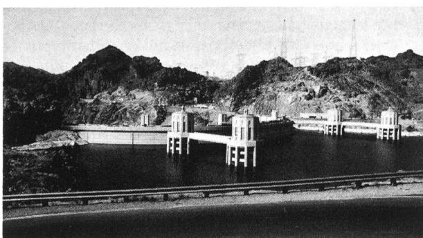
Figure 4. Les quatre ouvrages de prises, en forme de tours, en amont du barrage.
