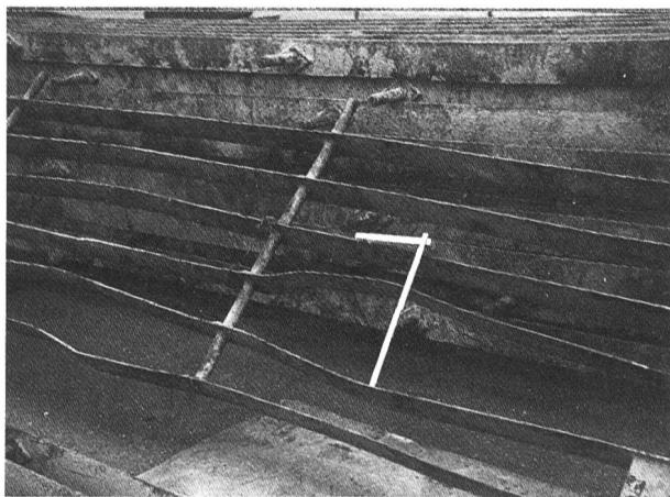
Bild 5. Deformierte Rechentafeln.
