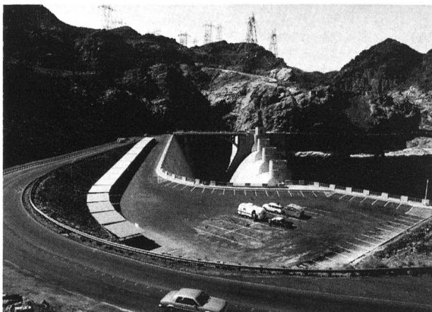
Figure 3. Les deux évacuateurs de crues, installés chacun d'un côté, ont une capacité totale de  $11\ 327\ m^3/s$ . Dimensions: longueur 198 m, largeur 45 m, hauteur 52 m. Les galeries attenantes ont un diamètre de 15 m.
