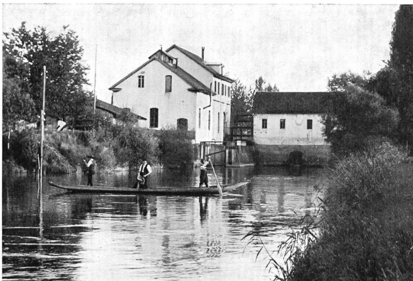
Bild 2 Das alte Werk und die «Gaserei» (spätere Werkstätte) vom Unterwasser aus gesehen. In der Bildmitte die 1889 erstellte Schiffahrtsschleuse.
