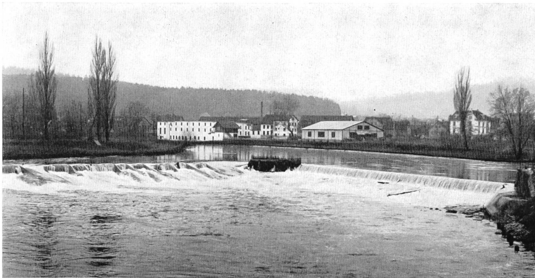
Bild 3 Das in den Jahren 1889 bis 1893 erstellte Wehr. In der Mitte die mit hölzernen Nadeln verschlossene Floßgasse. Die beidseitigen Flügel, auf denen die Klappen zum Teil stehen, zum Teil umgelegt sind, sind unregelmäßig überströmt. Das Aufstellen der Klappen geschah von einem an einem Fährseil verankerten Schiff aus, eine sehr zeitraubende und gefährliche Arbeit. Dieses Wehr wurde im August 1932 gesprengt.
