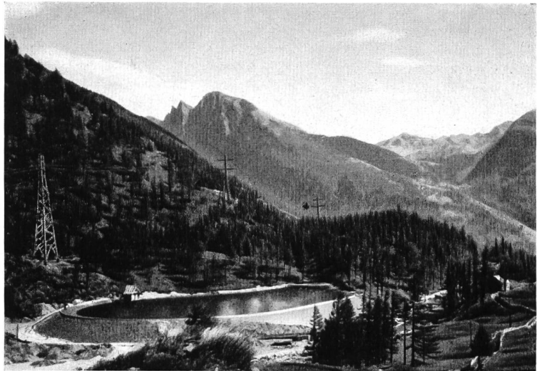
Bild 1 Ausgleichsbecken Eggen oberhalb Simplondorf nach der Fassung der vereinigten Krumm- und Wallibäche
