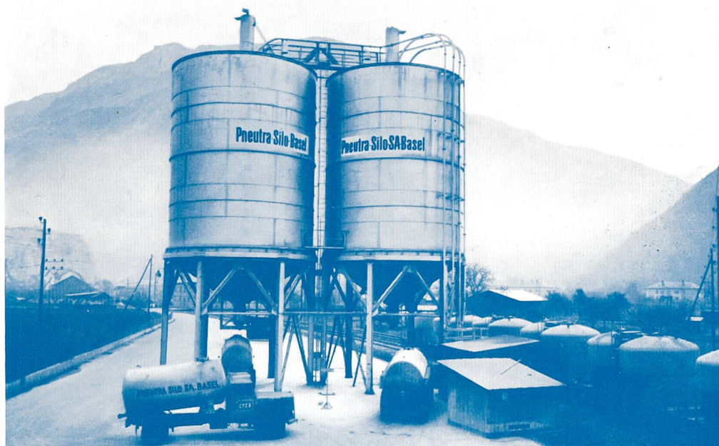
Umschlagsilos mit einem Fassungsvermögen von 1000 Tonnen pro Silo
