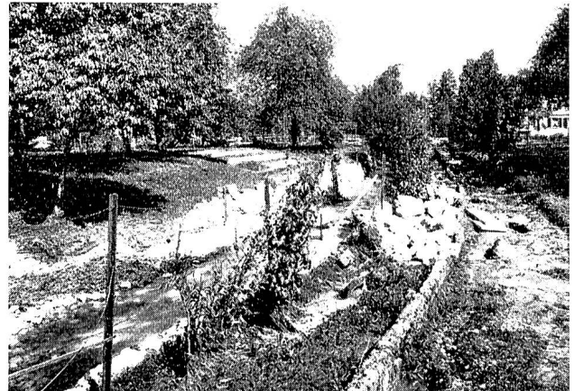
Abb. 10 Der Mühlebach bei Richterswil. Sohlenerhöhung und Geschiebeüberführung im unteren Dorfteil Encombrement du lit et dépôts de galets du «Muhlebach» près Richterswil (bas-village)
