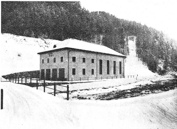
Abb. 5. Elektrizitätswerk St. Moritz. Ansicht der Zentrale „Islas“.
