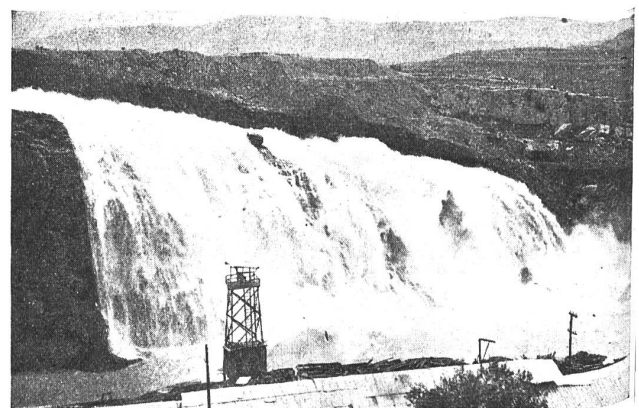
Abb. 4. Blick vom rechten Ufer auf den Hochwasser-Absturz
