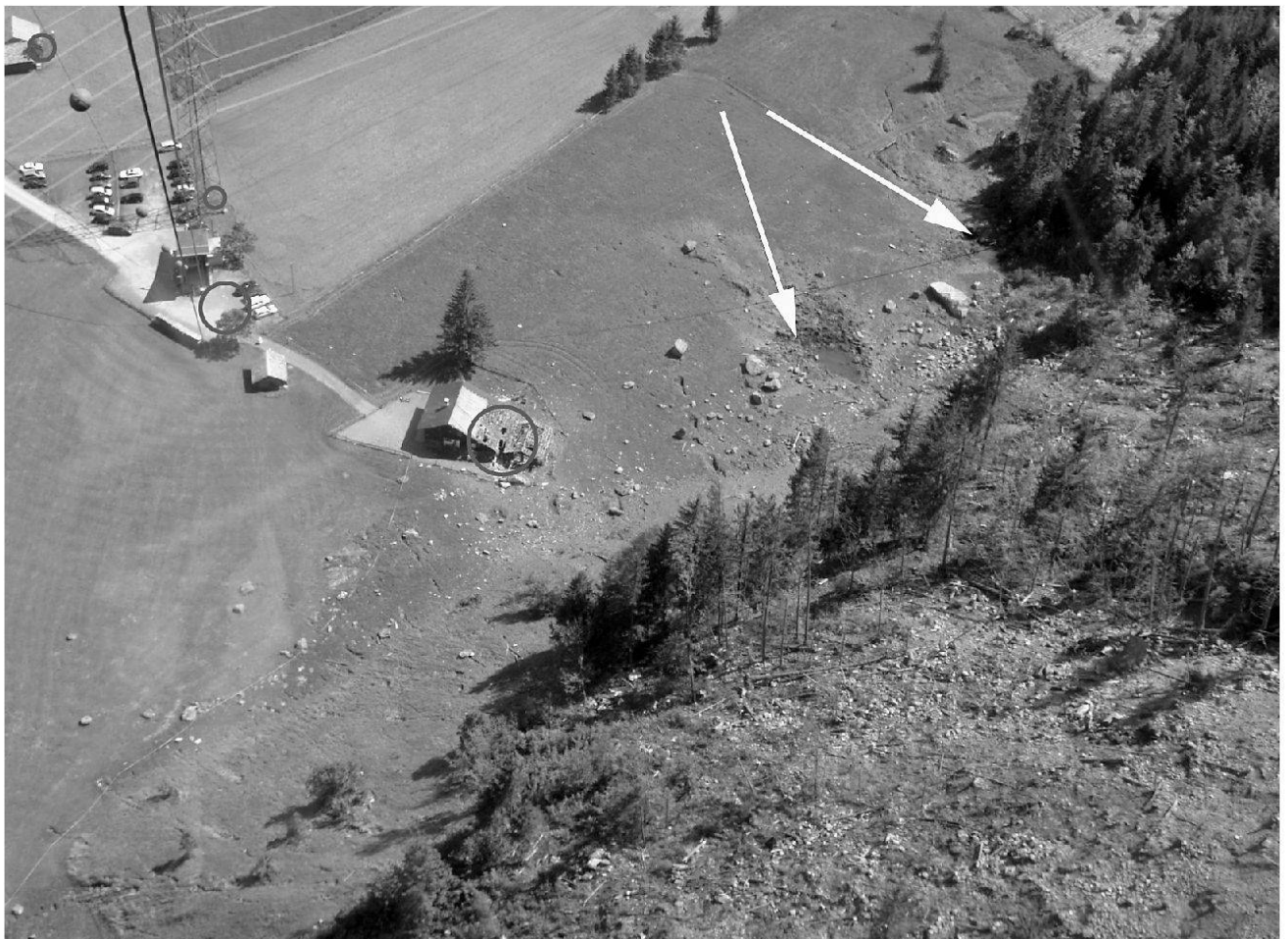
Fig. 2: Aufnahme des Sturzgebietes aus der Seilbahnkabine mit Streufeld der Blöcke, Einschlagtrichter von zwei Grossblöcken (Pfeile), beschädigtem Haus und Talstation der Allmenalpbahn. Kreise = Schäden durch Treffer von Steinen und kleinen Blöcken.
