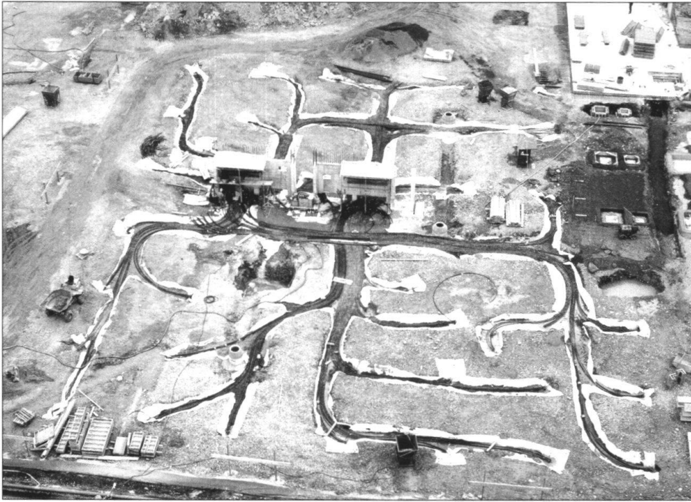
Fig.11: Überblick der beiden Verteiler sowie der im Sandbett verlegten Sondenzuleitungen und -ableitungen (Zustand Mitte Oktober 2001).
