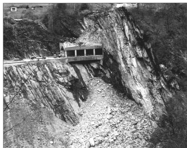
Fig. 14: Felssturz vom 4. April 2001 an der Nationalstrasse bei Mesocco.
