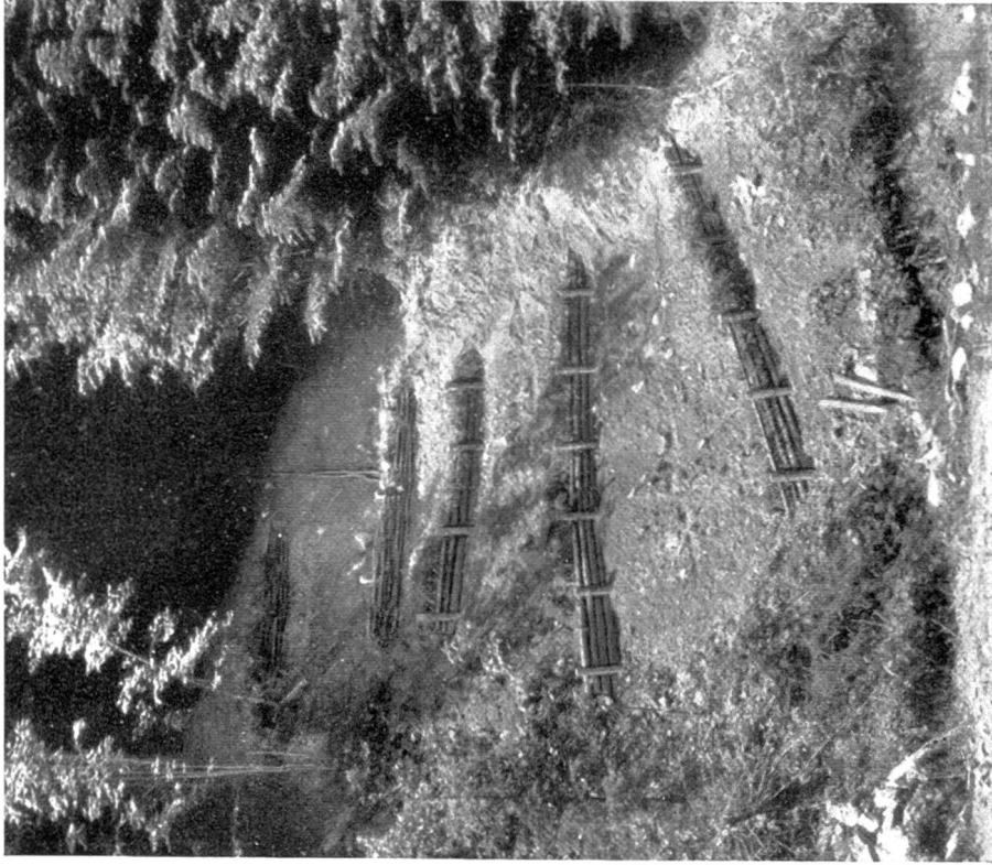
Bild 2. Kleiner Rutsch, oben abgebösch, verbaut, noch unbesät und unbepflanzt. (Unten Stangenhähe, oben Flechtwerk )
