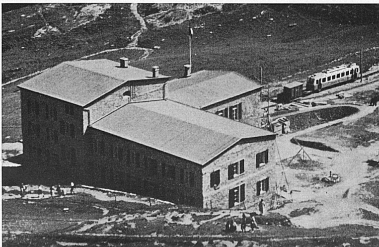
Das Berghotel auf dem Gipfel der Rochers-de-Naye wurde diesen Herbst vollständig erneuert und modernisiert. Es präsentiert sich heute in einer seiner Umgebung außerordentlich glücklich angepaßten Weise. — L'hôtel au sommet des Rochers-de-Naye a été modernisé cet automne. Ce nouveau bâtiment cadre particulièrement bien avec le paysage environnant.
