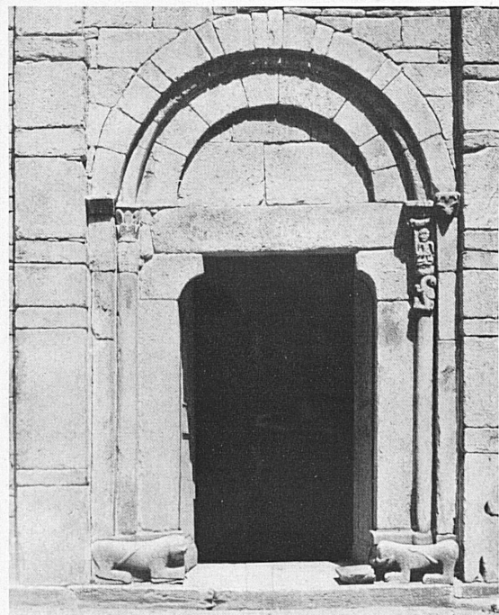
Von oben nach unten: Kapitell am Südportal. — Der Haupteingang an der Westfassade mit den säulentragenden, roh skulptierten Tierfiguren.
