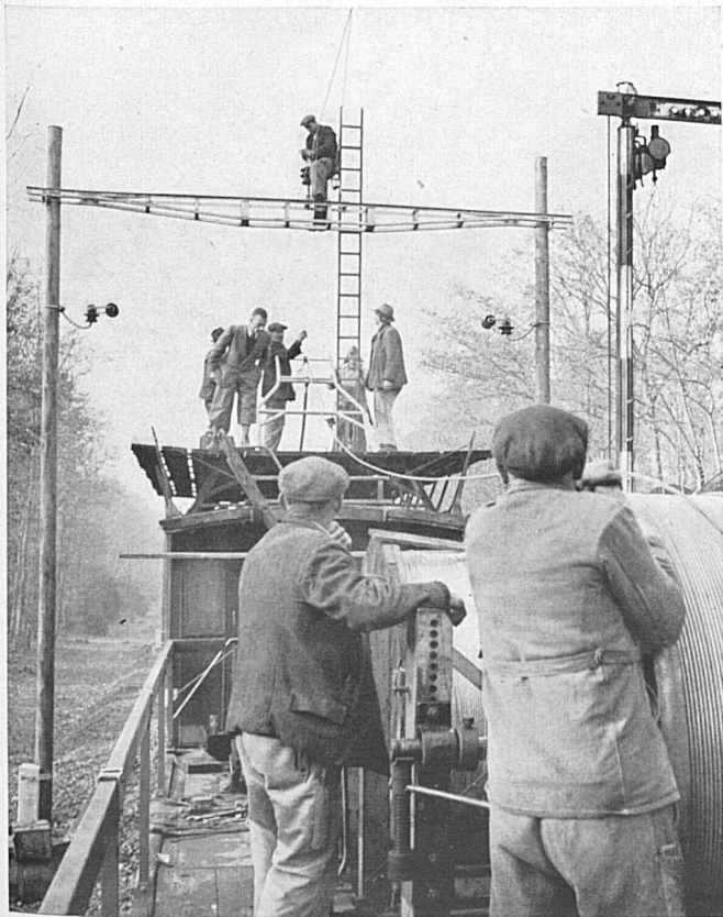
Der Fahrdrat wird montiert. Montage de la ligne de contact.
