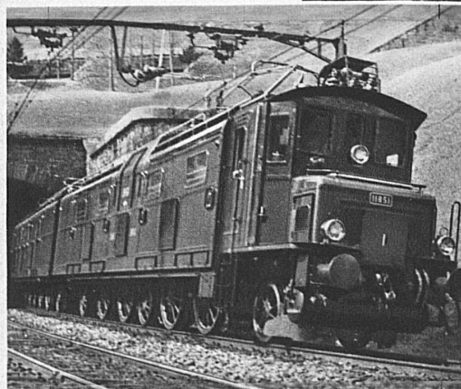
Eine der neuen grossen elektrischen Gotthardlokomotiven, die mit 8500 PS gewaltige Züge über die steilen Gotthardrampen hinaufführt
