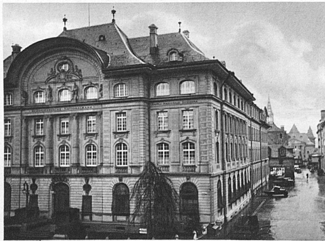
Das Amt für Verkehr befindet sich im Gebäude der Nationalbank am Bundesplatz in Bern
