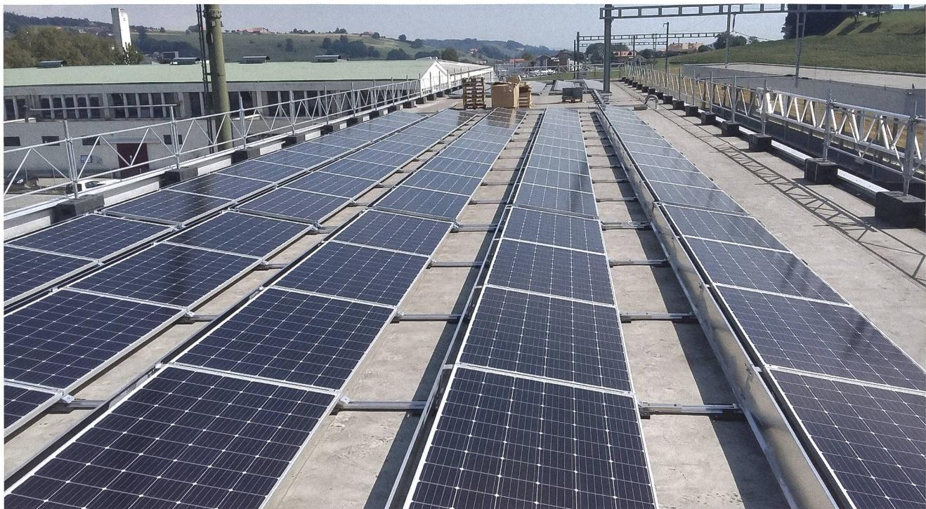
En collaboration avec un contractant, les Transports publics fribourgeois (TPF) ont réalisé des installations photovoltaïques sur les toitures des quais, sur quatre sites jusqu'à présent (sur la figure : la gare de Belfaux). La taille de l'installation PV est adaptée au potentiel de consommation propre de la gare en question. Environ 60 % du courant produit peuvent être consommés directement sur place (dispositifs de sécurité, publicité, distributeurs de billets, ventilation).
