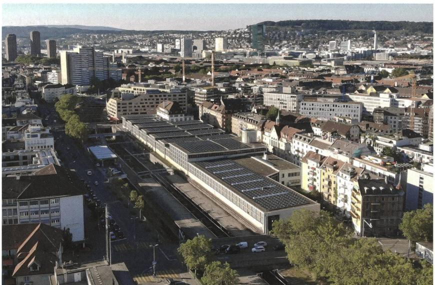
Dans le cadre d'un assainissement général, achevé en 2019, du dépôt de trams classé monument historique de l'Elisabethenstrasse, à Zurich, on a posé cette installation photovoltaïque de 470 kW, qui produit principalement du courant de traction pour les trams. À long terme, tous les dépôts de trams zurichoises seront équipés d'installations PV.
