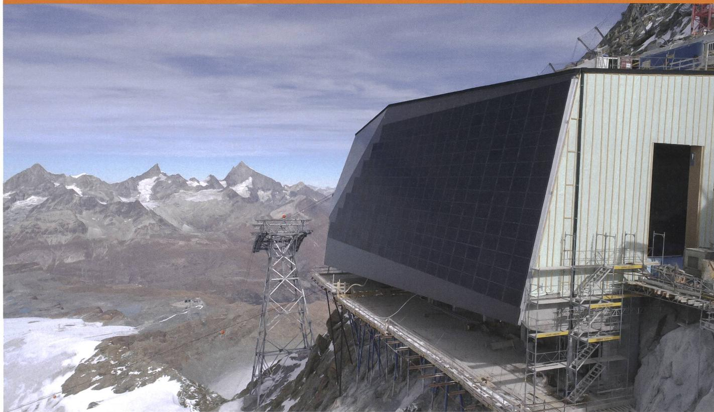
Diese 2019 erstellte Fassade der Bergstation Klein Matterhorn aus semitransparenten, verstärkten Solarmodulen und einer Leistung von 77 kW liegt auf 3821 m ü. M. und ist eine der höchstgelegenen Photovoltaikanlagen in Europa. Sie deckt rund 17% des benötigten Bahnstroms. Die vertikale Fläche ist bei tiefem Sonnenstand im Winter optimal ausgerichtet und durch die tiefen Temperaturen produzieren die Solarzellen besonders effizient Strom.
