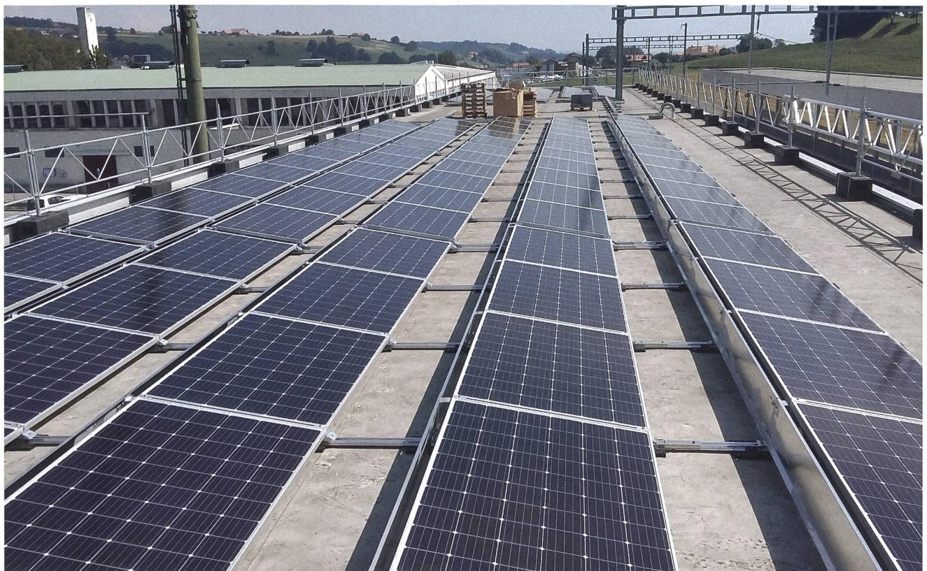
In Zusammenarbeit mit einem Contractor haben die Freiburgischen Verkehrsbetriebe (TPF) an bisher vier Standorten (im Bild der Bahnhof Belfaux) PV-Anlagen auf Perron-Dächern realisiert. Die Grösse der PV-Anlage wird auf das Eigenverbrauchspotenzial des jeweiligen Bahnhofs abgestimmt. Zirka 60 % des produzierten Stroms können direkt vor Ort verbraucht werden (Sicherheitseinrichtungen, Werbung, Billett-Automaten, Belüftungen).
