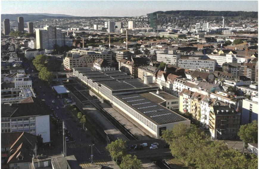
Im Rahmen einer 2019 fertiggestellten Gesamtsanierung des denkmalgeschützten Tramdepots an der Elisabethenstrasse in Zürich wurde diese 470-kW-Photovoltaikanlage erstellt, die vorwiegend Traktionsstrom für die Trams erzeugt. Langfristig sollen alle Zürcher Tramdepots mit PV-Anlagen ausgerüstet werden.
