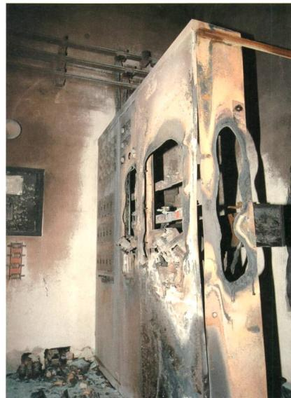
**Bild 4** Beschädigte Schaltgerätekombination durch Kurzschluss.
