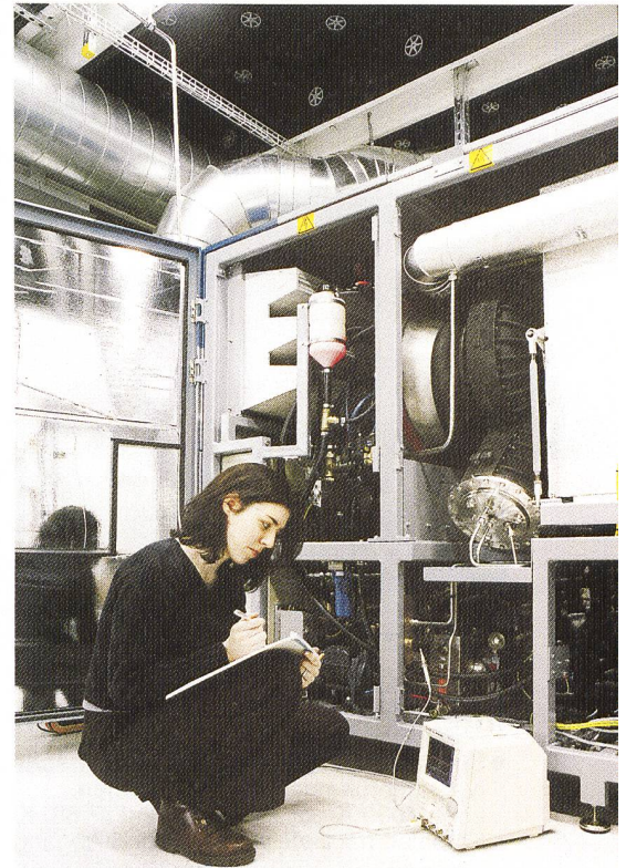
Bild 4 Versuche an einer KWK-Anlage im ABB-Forschungszentrum in Baden-Dättwil.
