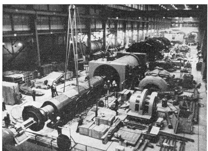
**Fig. 7 Einführen des Rotors in den Generator im Kraftwerk
