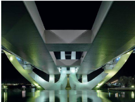
Die Sheikh Zayed Bridge mit ihrer skulpturalen Konstruktion erscheint bei Nacht in Farbe getaucht (Foto: Christian Richters)
