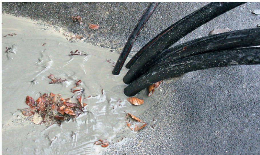
01 Die Wahl eines thermisch besser leitfähigen Hinterfüllmaterials ist eine einfache Massnahme, um die Effizienz einer Erdwärmesonde zu verbessern (Foto/ Grafik: Autor)
