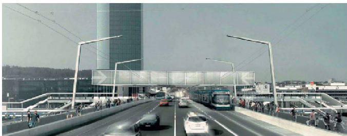
08+09 «Tofteryd»: Das grosse Lichtdach über der Hardbrücke wirkt wie ein Stadttor: Darunter ist eine 65 x 75 m grosse, rautenförmige Plattform auf vier Kernen gelagert. Zur Verteilung der Personenströme reichen die Verbindungen weit in Richtung der Perronköpfe (Bilder: EM2N Arch.)
