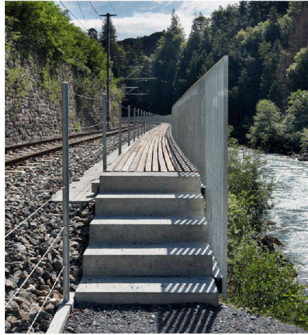
06 Viaduktsteg entlang der RhB-Linie am Flussufer
