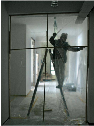
Arbeiter beim Innenausbau in einem Zürcher Bürohaus (Foto: KEYSTONE/Gaetan Bally)
