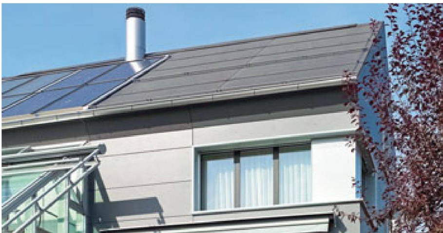
01 Fassaden- und Dachsanierung mit Eternit (Foto: Eternit Schweiz AG)
