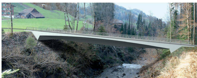
06 «Duett»: Suggestiert ein Kräftespiel – Spannbetonbrücke mit zwei untenliegenden geschwungenen Längsträgern
