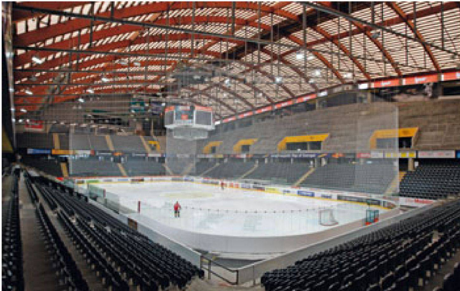
01 Die Dachkonstruktion aus Holz der renovierten PostFinance-Arena in Bern blieb erhalten
