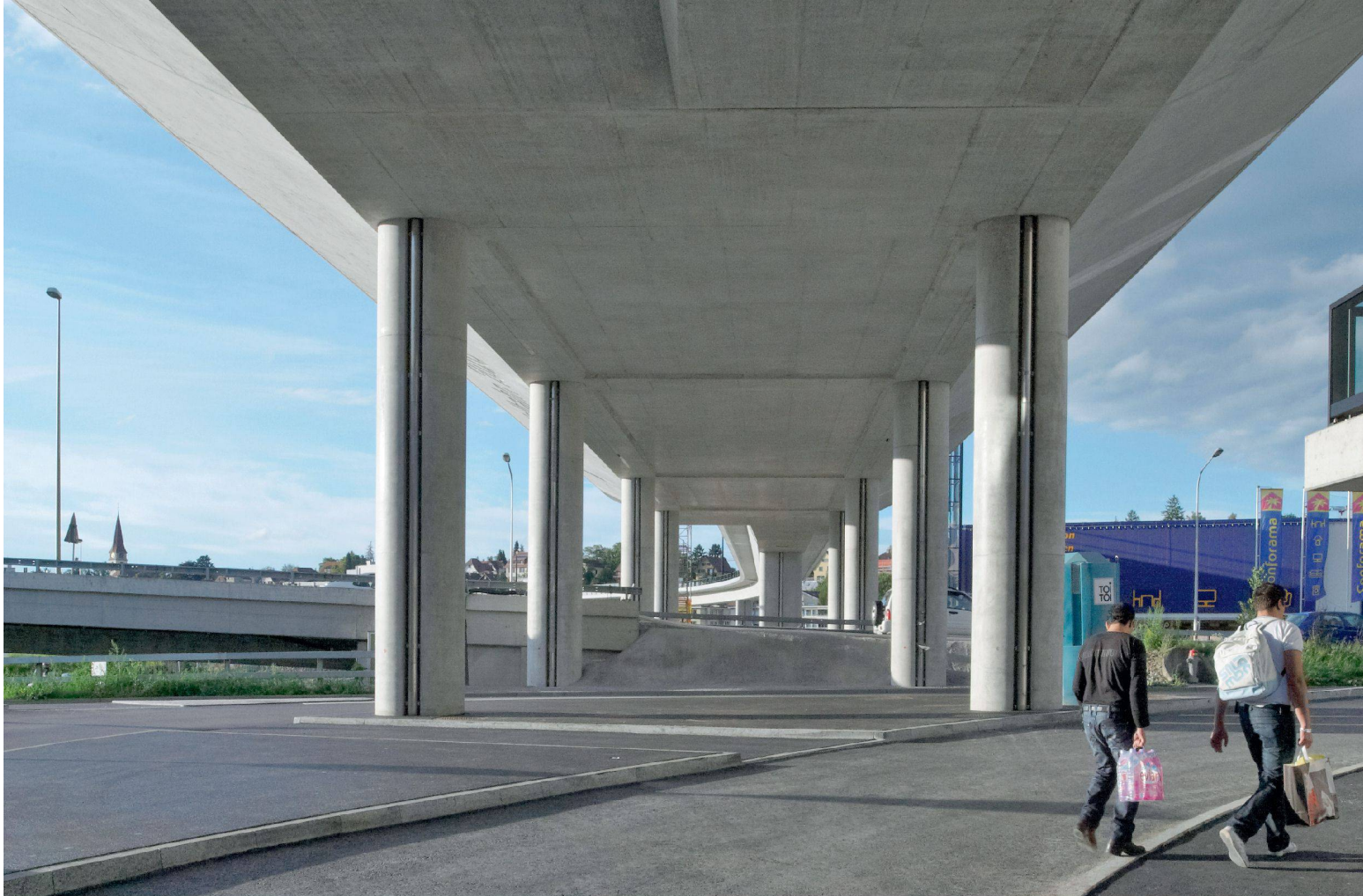
01 Trasse der Glattalbahn / Tramway du Glattal / Tranvia della Glattal (Foto/photo/foto: Theodor Stalder)
