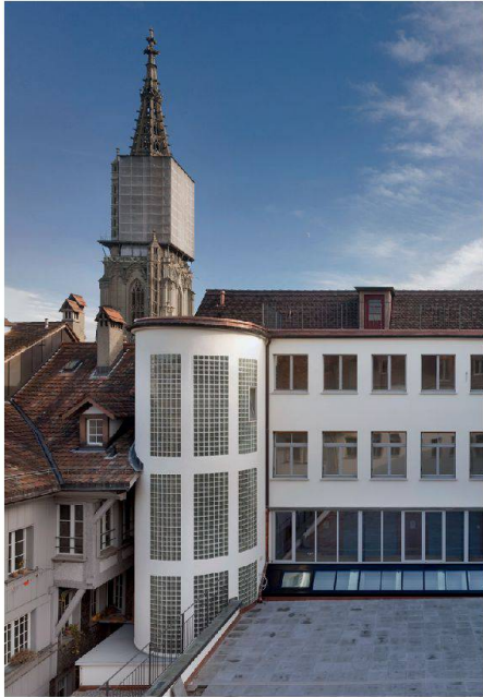
01 Die Dachterrasse verbindet den Bau an der Kramgasse im 2. OG mit dem an der Rathausgasse (Fotos: Alexander Gempeler)
