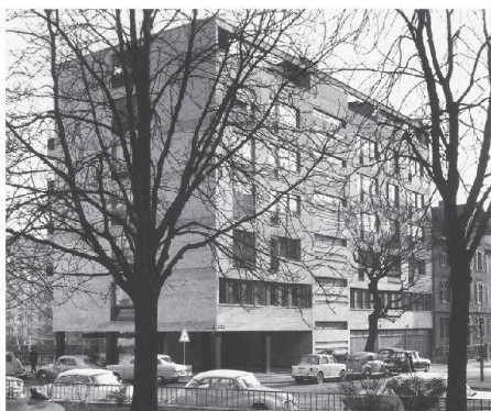
01 Büro- und Geschäftshaus Seefeldstrasse 152, Zürich (1957–1960) (Foto: «Nachkriegsmoderne Schweiz», Basel, Boston, Berlin 2001)
