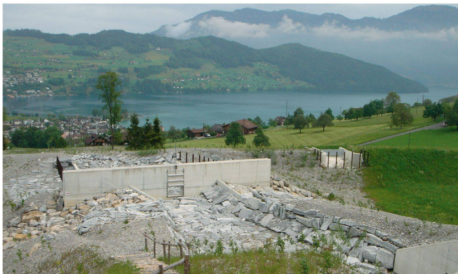
01 Retentionsbauwerk am Rübibach, oberhalb von Buochs (Foto: Jenny Keller)
