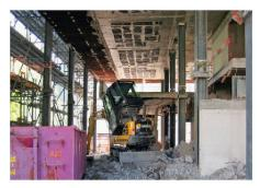
04 Rück- und Umbau des Zwischengeschosses, das neu bis zu den peripheren, hier noch zweigeschossigen Fassadenpfeilern reichen soll, erforderten eine detaillierte Planung der Etappierung (Bild: Paul Lüchinger)
