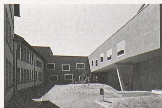
Erweiterung Schulanlage Schanz in Rüti (Felber Keller Lehmann)
