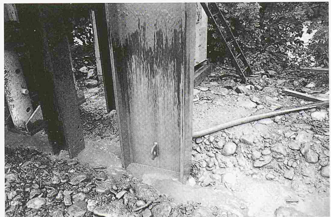
Das einviertel Profil wird gezogen und die Suspension injiziert
