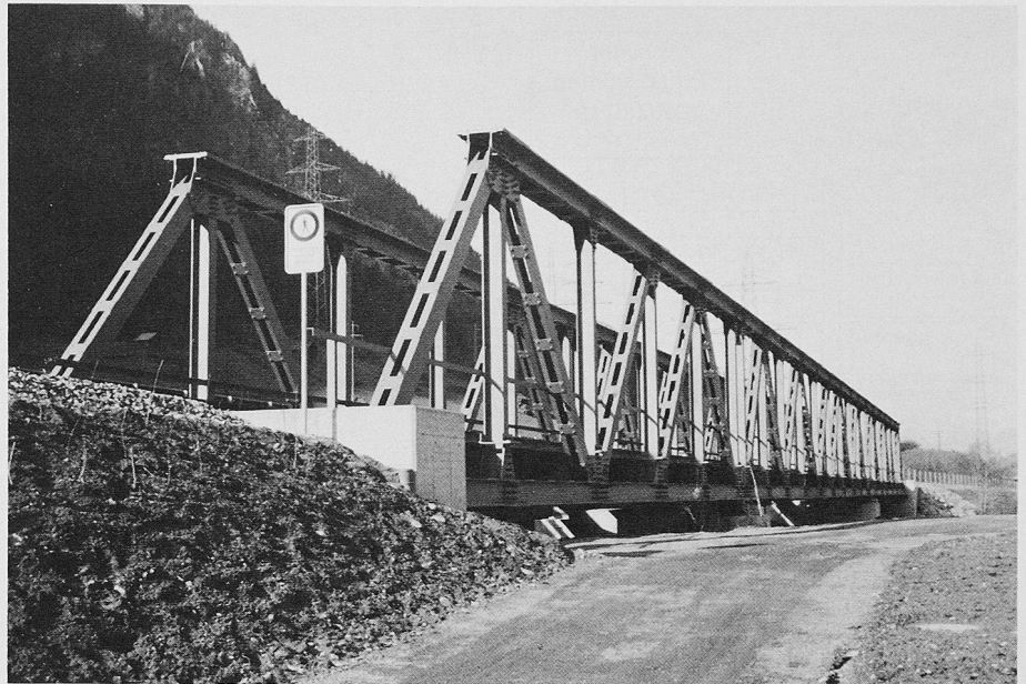
Bild 7. Brücke Silenen, Modell SKR, Blick flussabwärts
