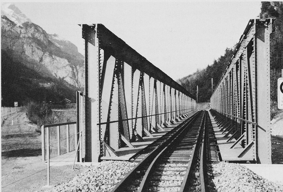
Bild 6. Brücke Erstfeld, Modell 1936. Sichtbar sind die vielen Schrauben und die Fangschiene als Entgleisungsschutz
