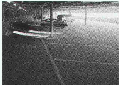
Parkdeck Glattzentrum, Wallisellen
